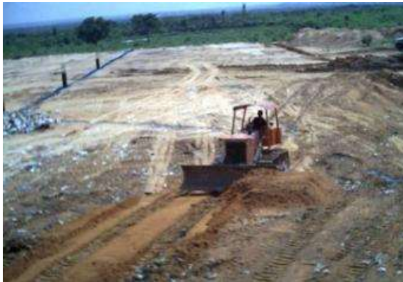
Figura 1. Aterramento do lixo urbano, nos primeiros meses de funcionamento do Aterro Sanitário. Fonte: SOUSA, 2004.
