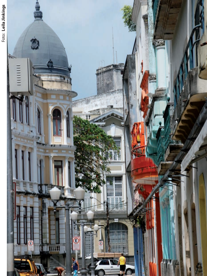
TRADICIONAL Prédios do Bairro do Recife precisam de manutenção
