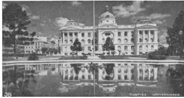
Figura I – Prédio antigo da Universidade Federal do Paraná.
